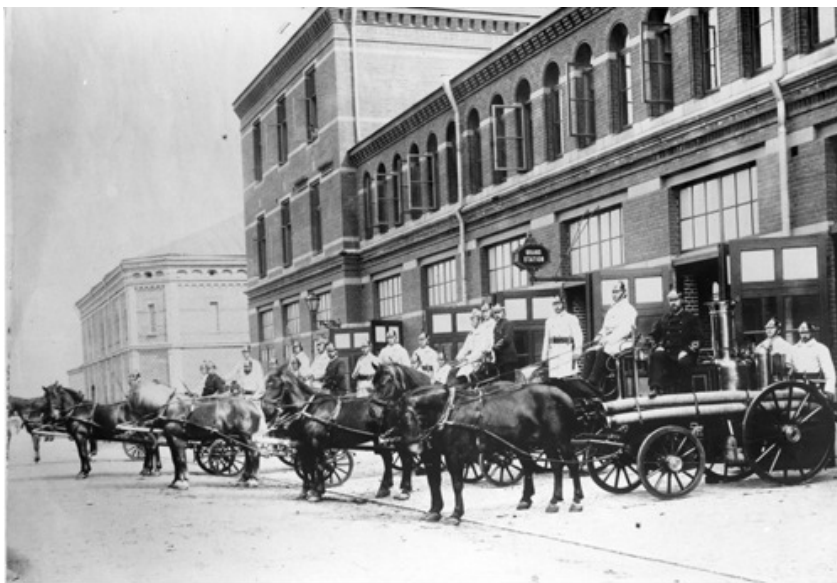
Huvudbrandstationen vid Nordhemsgatan
